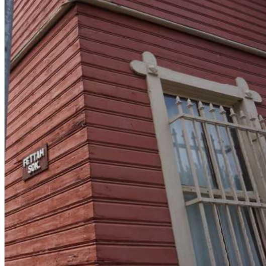
Heybeliada Fettah Sokak I / Uygun Cephe Kaplaması Örneği-Ahşap
