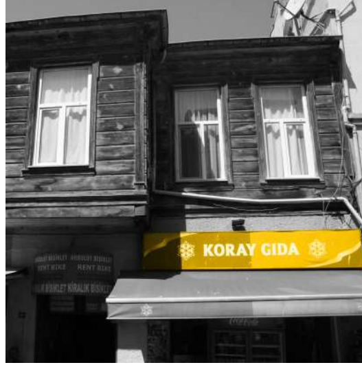
Uygun olmayan zemin kat tabela örneği
