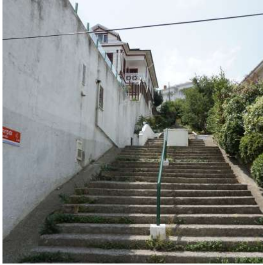
Merdivenli sokaklar için temel prensipler Ayışığı Sokak - mevcut görünüm
