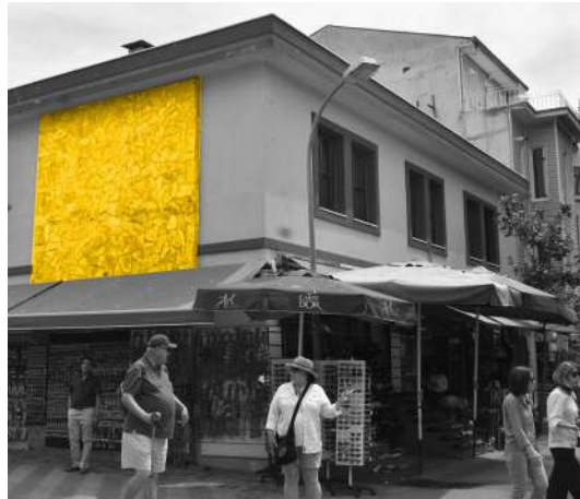
Büyükada 248 ada 5 parsel / Uygun olmayan parçacıl ve uygun olmayan kaplama malzemesi örneği
