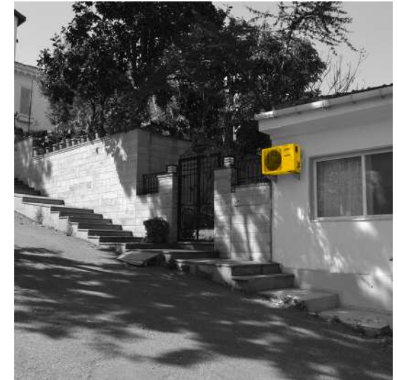
Burgazada 45 ada 7 parsel / Örnek Uygunsuz cephe eklentileri – klima
