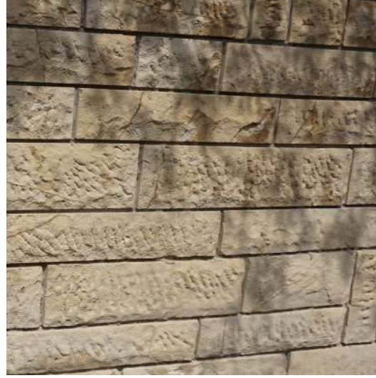
Burgazada Sarnıç Sokak / Uygun Cephe Kaplaması Örneği
