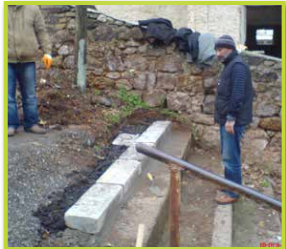
Taş Mektep Merdivenli Yol Tamiri Çalışmaları
