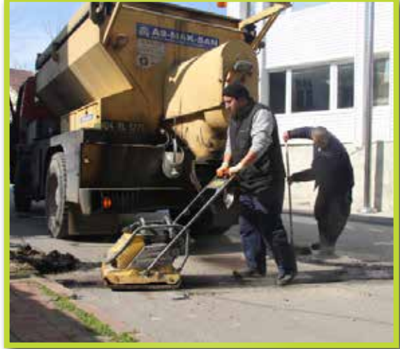
Yol Asfaltlama Çalışmaları Yapıldı.
