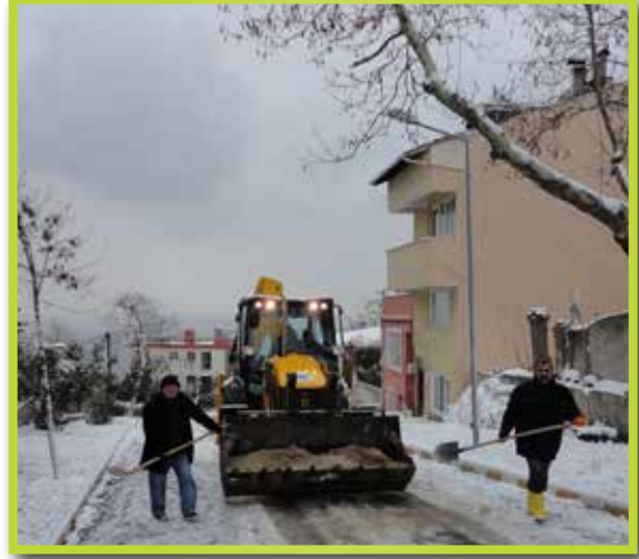
Yol Tuzlama Çalışmaları
