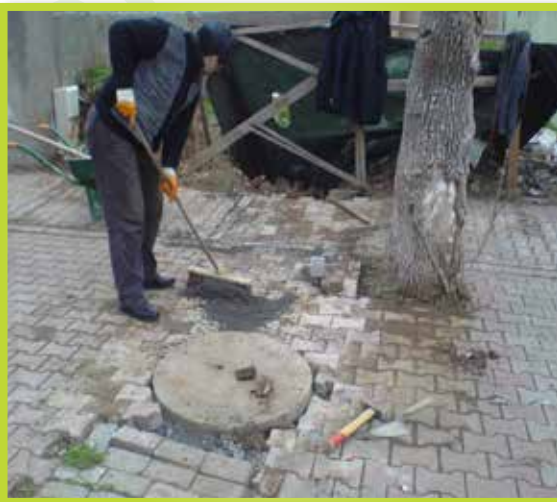
Tretuvar ve Parke Taşı Yol Tamiri Çalışmaları
