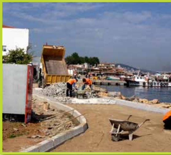
Yola Taş Döşeme Çalışmaları
