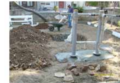
Aydoğdu Parkı spor aletleri yerleştirilirken
