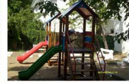
Aydoğdu Parkı bakım çalışması
