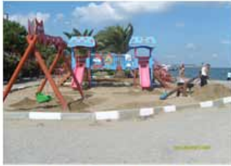
Demokrasi Parkı yapılan bakım çalışması
