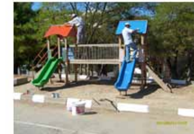
Şehit Murat Yüksel İlköğretim Okulu sonrası
